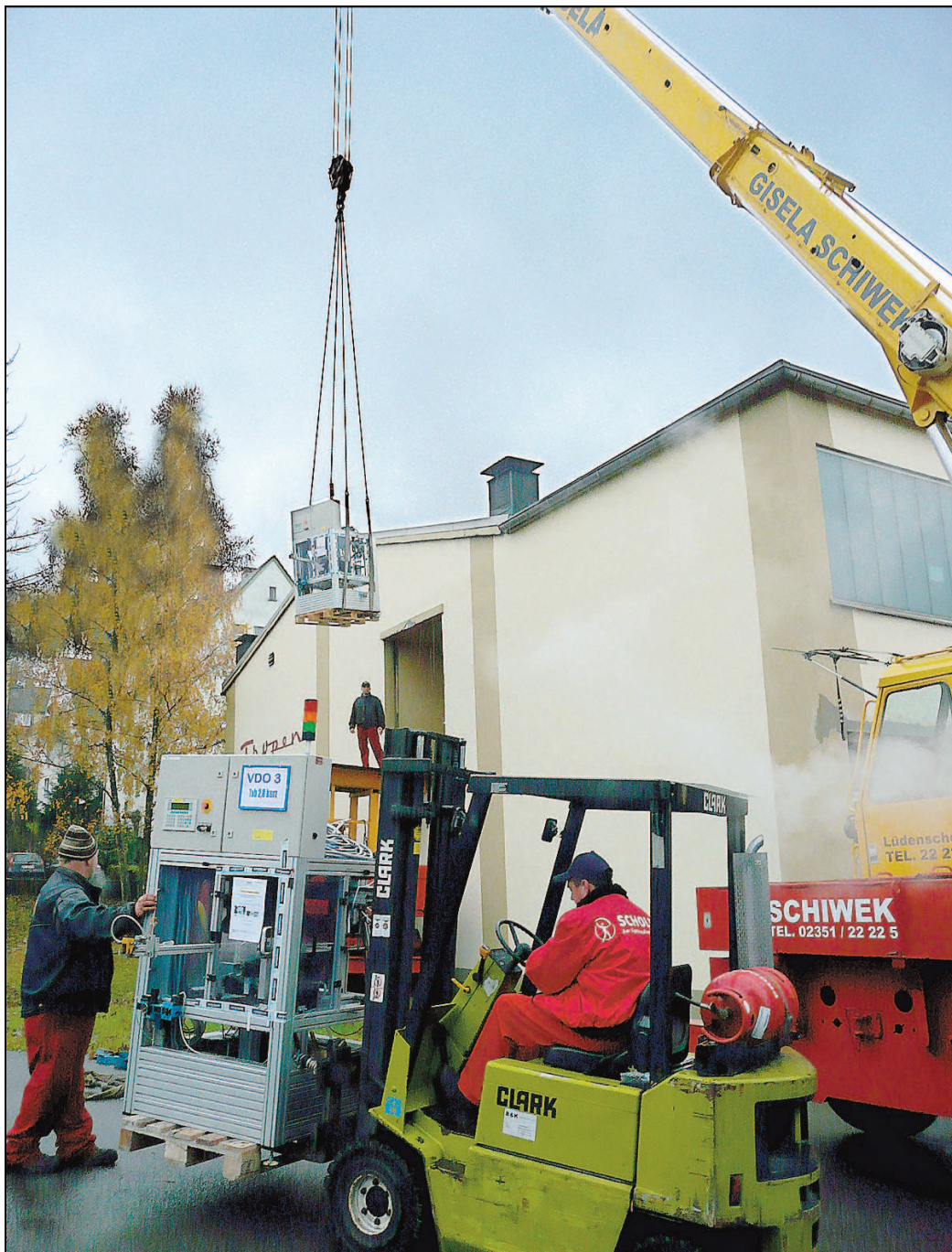
Stück für Stück wird die zerlegte Montagestraße per Schwerlastkran ins Obergeschoss der Firma Tropen Kunststofftechnik gehievt. ■ Foto: wok MK-TV-Beitrag auf www.come-on.de →
